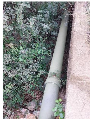
*Vue du correc dels Avencs en amont du busage, en mai 2022 à gauche. Conduite d'irrigation en encorbellement en octobre 2023 à droite.*
